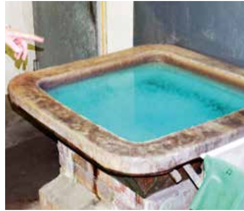
Das Beizbecken wird alle zehn Jahre erneuert.
